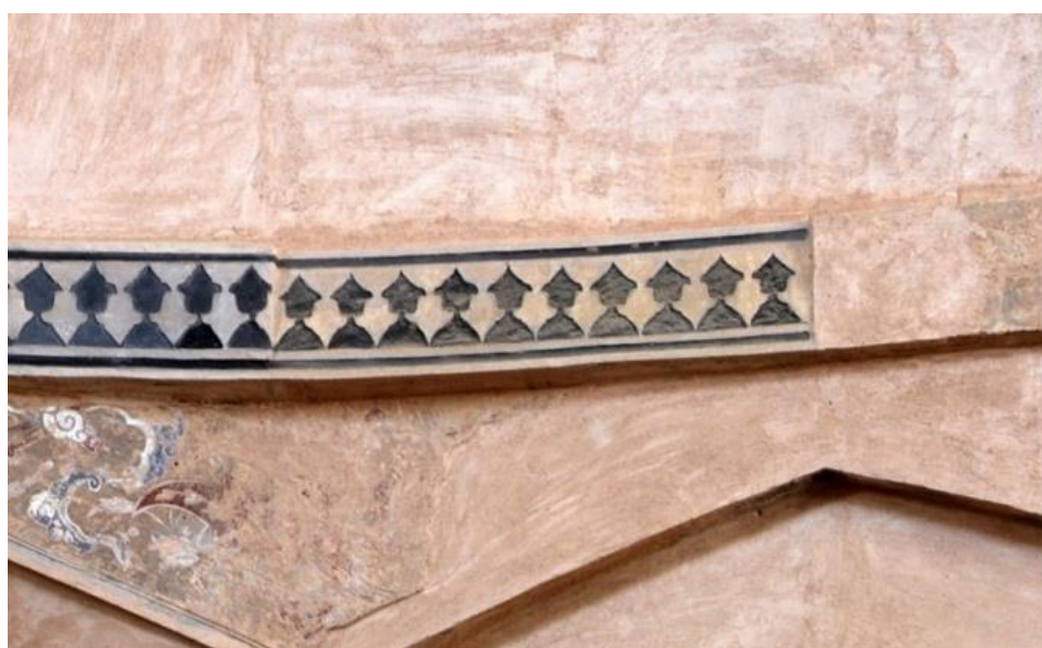
تصویر ۵- نمونه ای از آهک بری حمام شاه، قاجار، مآخذ: نگارنده
